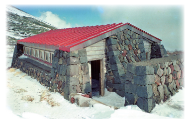
(写真4) 初代の不動平公衆便所 (昭和59年11月撮影)
